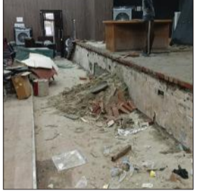
पालिका के सभागार में निर्माणाधीन कार्य। -जागरण मोर्चा
