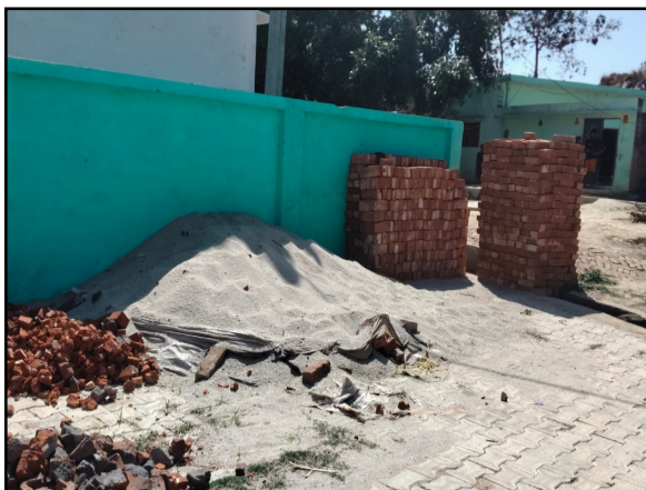
निर्माण कार्य के लिए लगाई गई इंटरलॉक की बर्मा में पाड़ा रें मटेरियल
