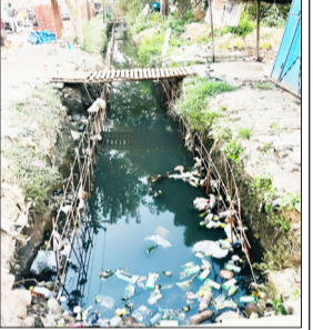
ज्वाला नगर में नाले निर्माण के लिए बनाए गए पिलर।
