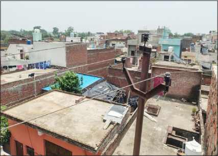
घटनास्थल से पास से गुजर रही हाईटेशन लाइन।
