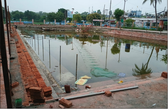
संजय रेलवे पार्क के छठ पूजा स्थल पर चल रहा निर्माण कार्य।
