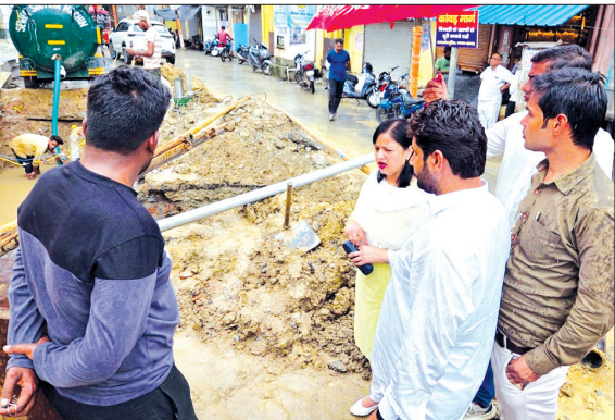
चंदौसी में नाला निर्माण कार्य का निरीक्षण करती पालिकाध्यक्ष।
