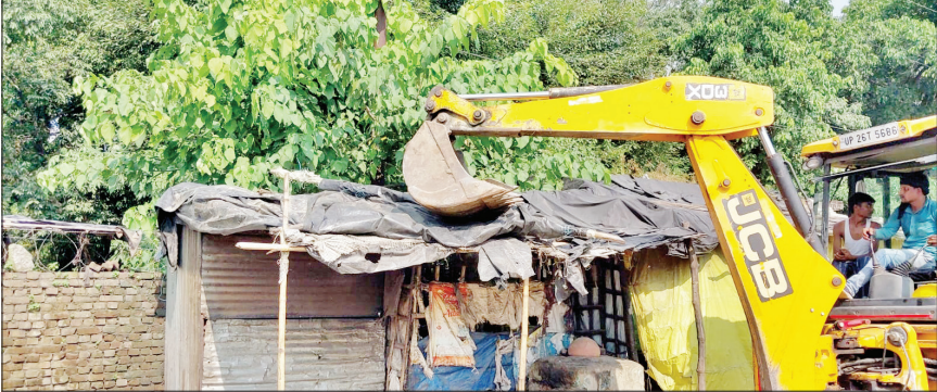
पूरनपुर में बुलडोजर से हटाया अतिक्रमण।
